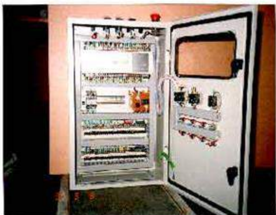
Fig.3 Panou de automatizare cu PLC
