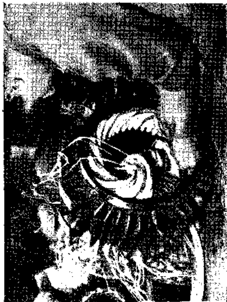
Fig. 10.126. Introducerea în creștături a bobinelor înfășurătorilor de curent alternativ, în două straturi, cu bobine egale, cu capetele de bobine dispuse în coroană de bobine :
