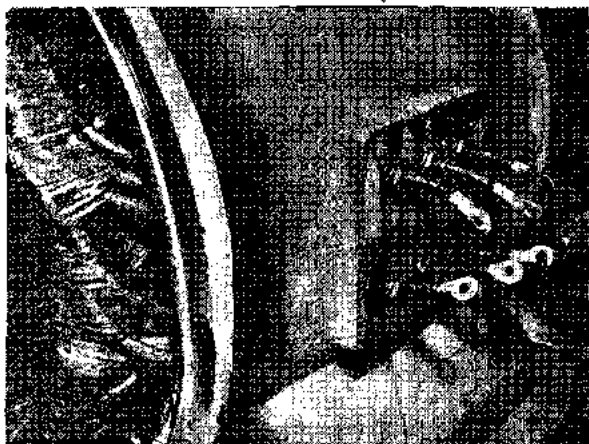
Fig. 8.12. Borne realizate cu cabluri flexibile.
