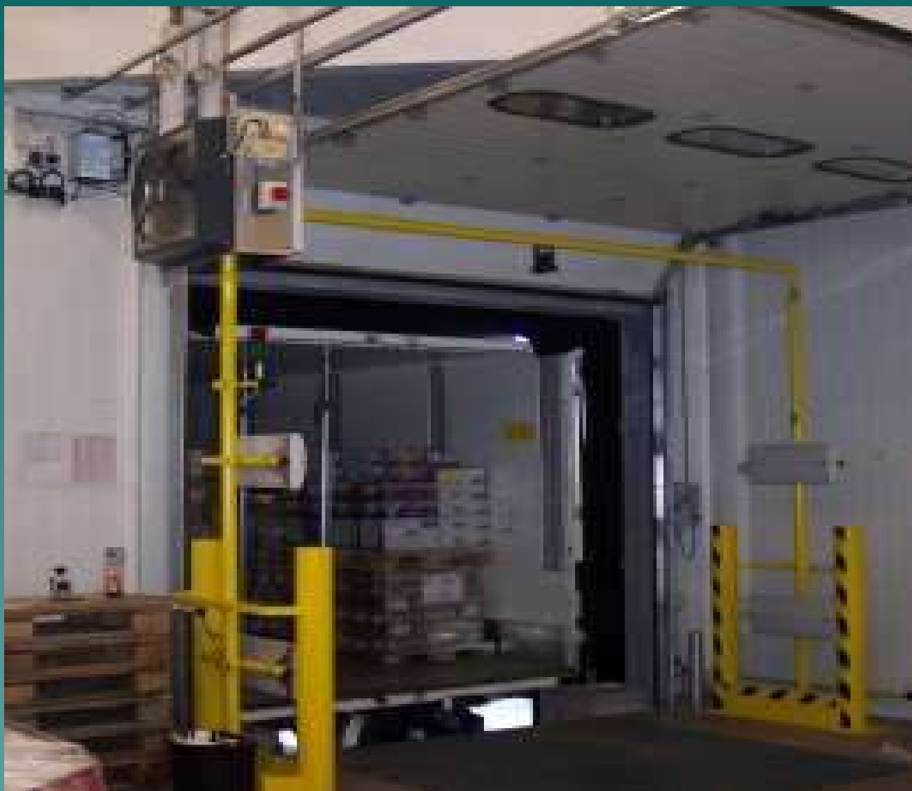
Figura 5 Rampe de distributie dotate cu sisteme RFID-UHF
