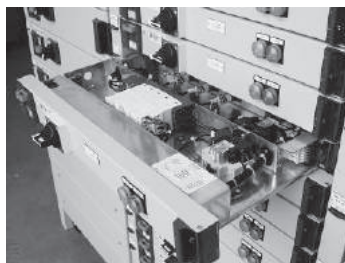
Fig. E32: Tabloul de distribuție cu unități funcționale în sertare deconectabile.
