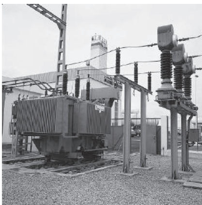
Fig. B25: Transformator cu conservator (tancul de ulei la presiunea atmosferică).
