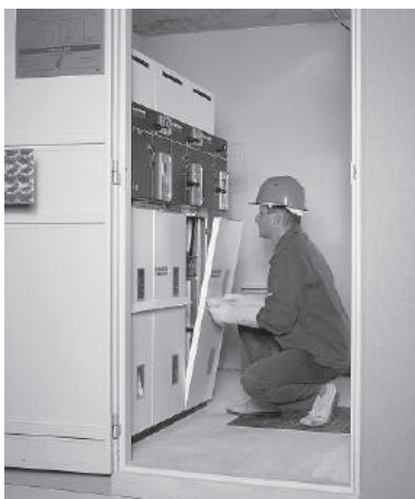
Fig. B34: Post de transformare de exterior cu cabină - cu operare din interior
