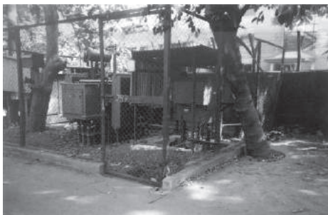
Fig. B36: Post de transformare de exterior fără cabină.
