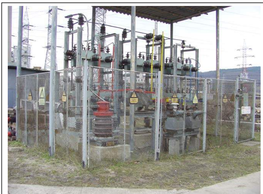
Fig.6.5. Baterie de condensatoare într-o stație electrică exterioară
